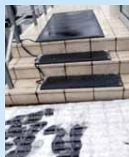
《ヒートマットの設置例》
