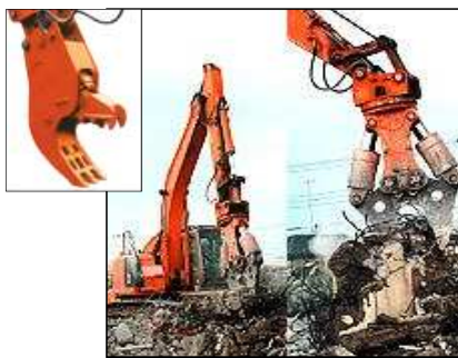
日立建機株式会社製、同社提供 (上写真右はコンクリート圧砕機(大割)・左は同(小割))
