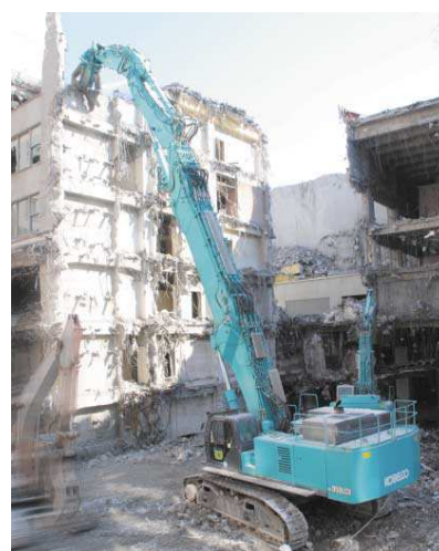
特定解体用機械のコンクリート圧砕機 コベルコ建機株式会社製、同社提供
